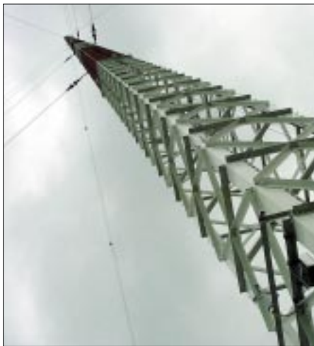
Eine der 360 m hohen Sendeantennen in Donebach
